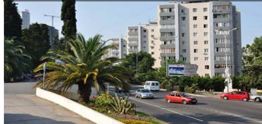
Реконструкция жилого квартала г. Сочи
